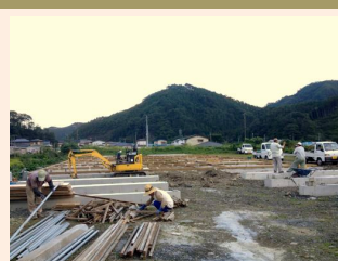
校舎建設現場の様子
